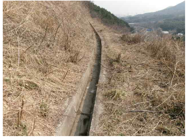
2소단 배수로 전경
