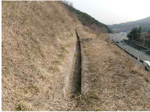
1소단 배수로 전경
