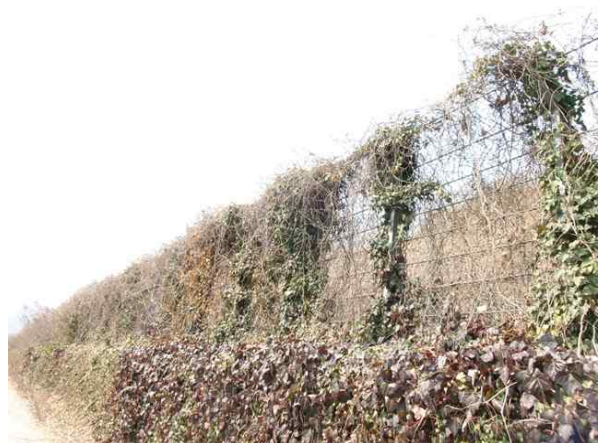
낙석방지울타리 및 하부 전경
