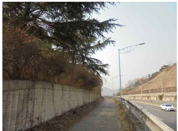
낙석방지울타리 및 하부 전경
